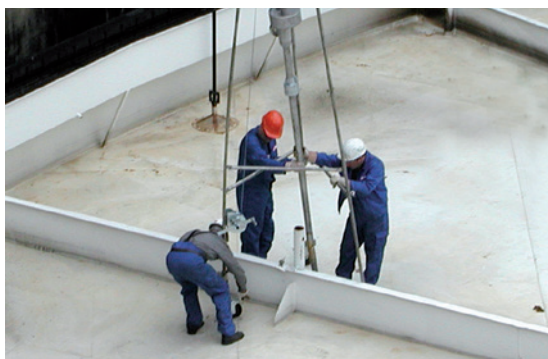
Les unités dites jet-washer sont installées à travers plusieurs béquilles du bac
